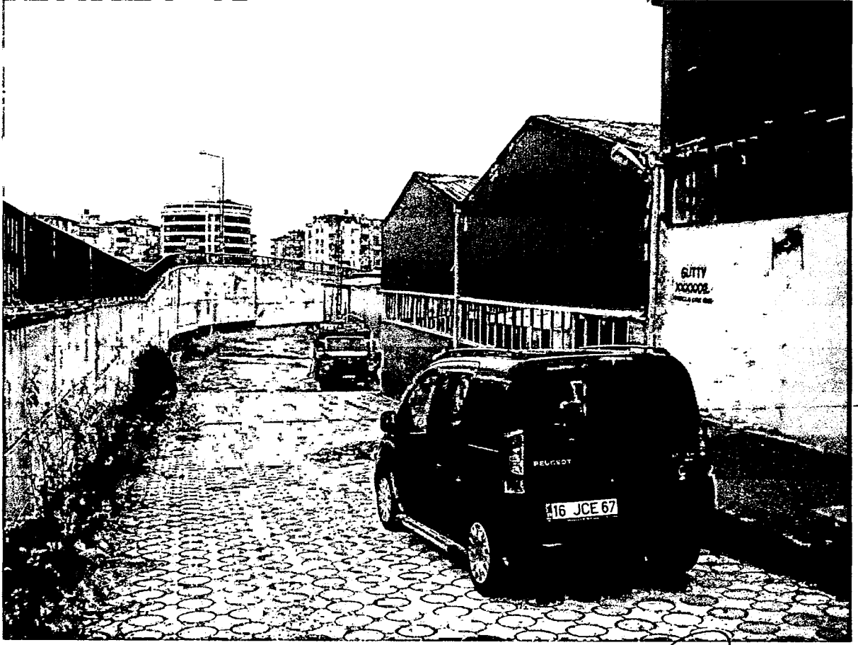
FOTOĞRAF 1: İNCELEME ALANI VE SONDAJ ÇALIŞMASI
